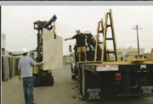
*Chargement d'une dalle sur un camion à plate-forme muni d'un support*
